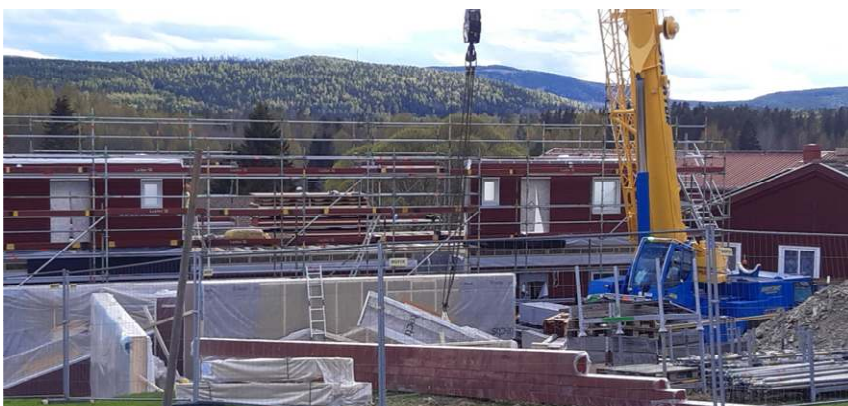
Fredagen den 13 maj hade ytterväggarna på nedervåningen och två lägenheter på övervåningen kommit på plats.
