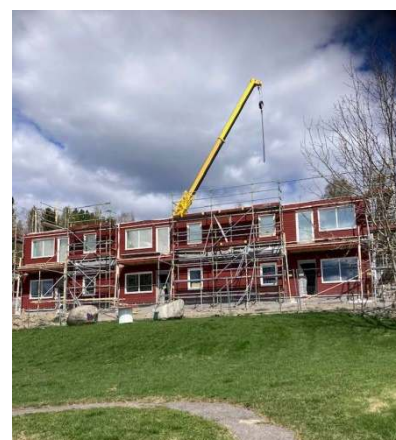
15 maj. Det tar sig på bygget!
